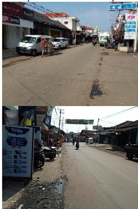
Gambar 1 Kondisi Prasarana Jalan Yang Tidak Dilengkapi oleh Saluran Drainase.
