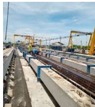
Gambar 10. Proses perakitan tulangan sengkang
