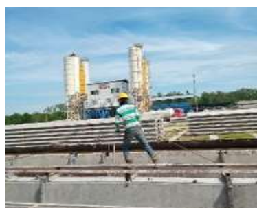
Gambar 8. Pemasangan Strand
