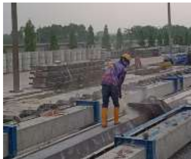
Gambar 7. Proses Pelumasan Pada Cetakan
