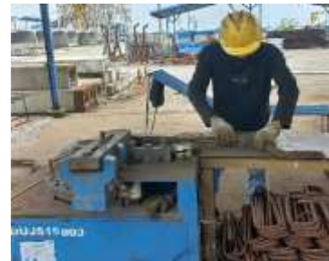
Gambar 4. Proses pembengkokan besi tulangan CCSP
