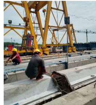
Gambar 17. Proses Pemotongan Strand
