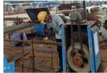
Gambar 3. Proses Pemotongan Besi Tulangan CCSP
