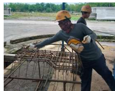
Gambar 5. Proses Pembengkokan Besi Tulangan CCSP
