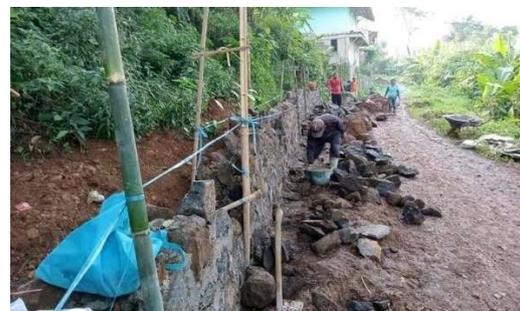
Gambar 3. Pekerjaan Pembangunan Dinding Penahan Tanah (DPT)
