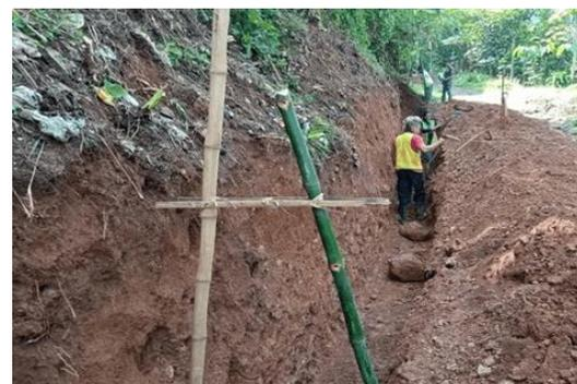
Gambar 4. Pekerjaan Pembuatan dan Pemasangan Bowplank
