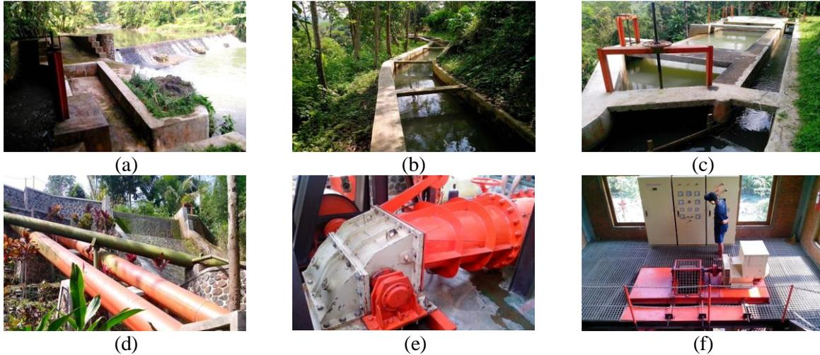
Gambar 2 Sistem-sistem utama pada PLTMH, (a) Bendung dan Intake, (b) Saluran Pembawa, (c) Bak Penenang, (d) Pipa Pesat, (e) Turbin *Cross Flow*, (f) Generator dan Panel Kontrol
