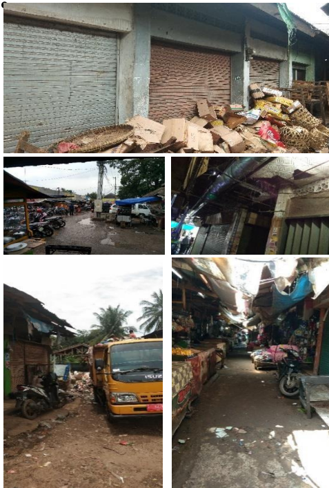
Gambar 2 - Kondisi Eksisting Pasar Kalijati.
