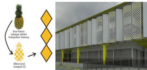
Gambar 6 - Secondary Skin pada Fasad Bangunan.
